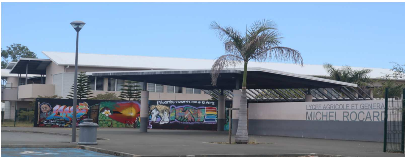
La rénovation des locaux d'origine du lycée agricole de Pouembout Michel ROCARD
