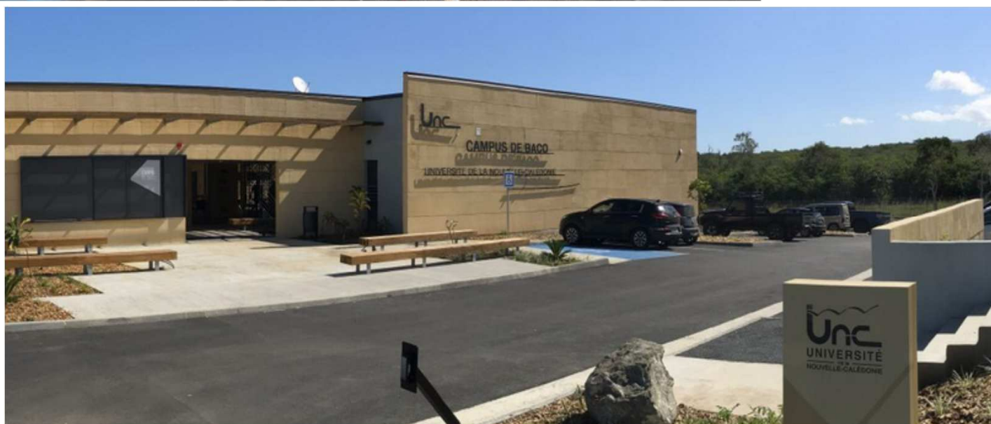
La construction de l'antenne de l'université à Baco et son extension
